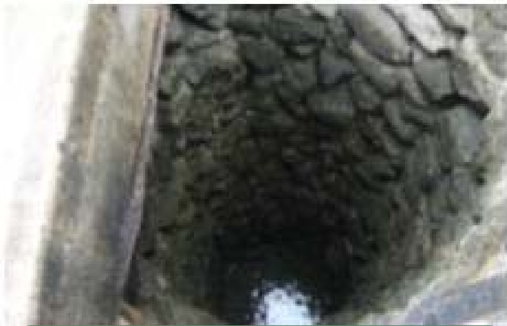
Hệ thống giếng quan trắc nước ngầm
